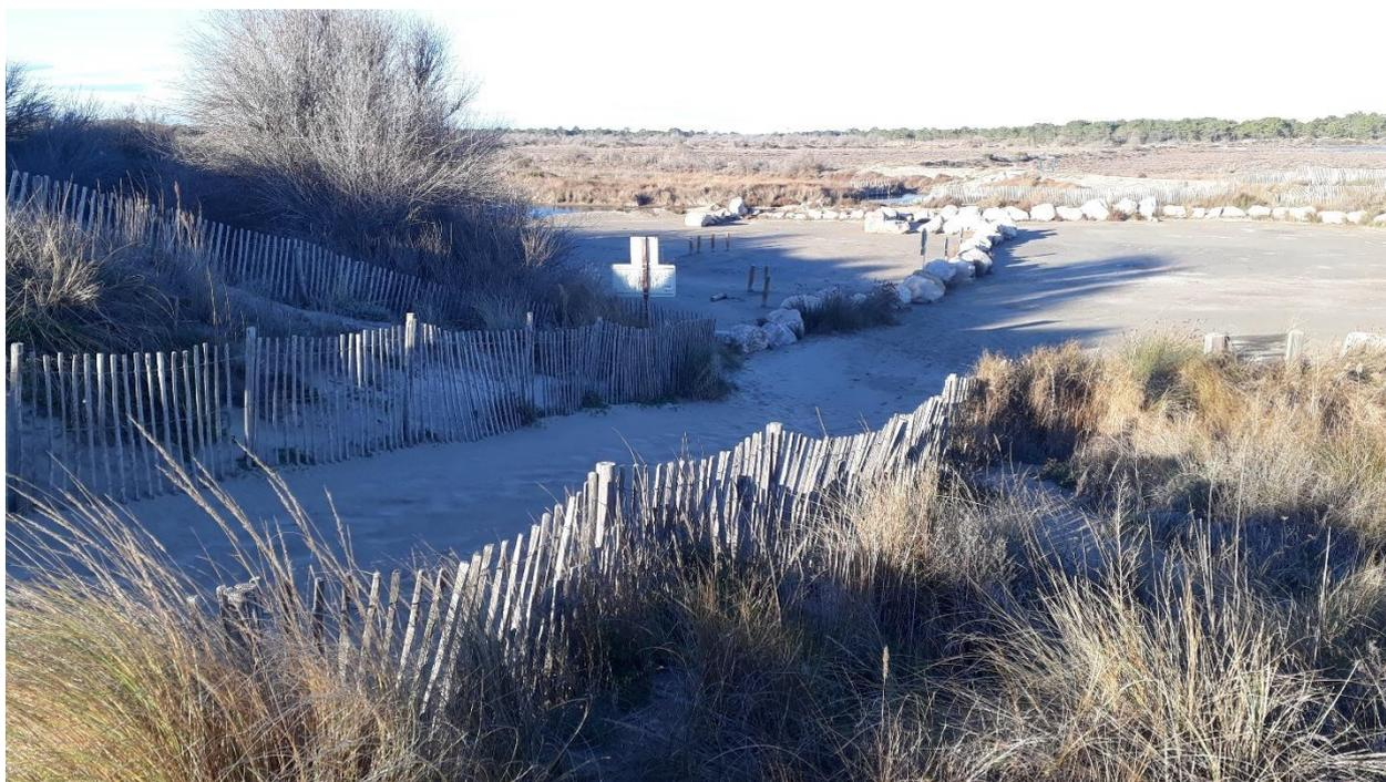
Vue de la partie centrale de l'emprise des travaux ; la présence de l'accès véhicules maintient une faiblesse altimétrique du cordon dunaire ; il sera fermé et comblé ; l'aire de stationnement visible en haut à droite sera réduite (photo EID 2021)
